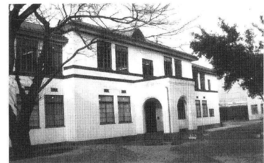
修復された旧本館 (現、石井亮一・筆子記念館)
